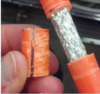
13. Corte tiras de 15 a 20 cm do envoltório de folha de cobre para aplicar sobre a malha.
